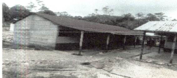
Foto 4 Se cambiara las ventanas.
