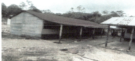
foto 5 se colocara puertas.
